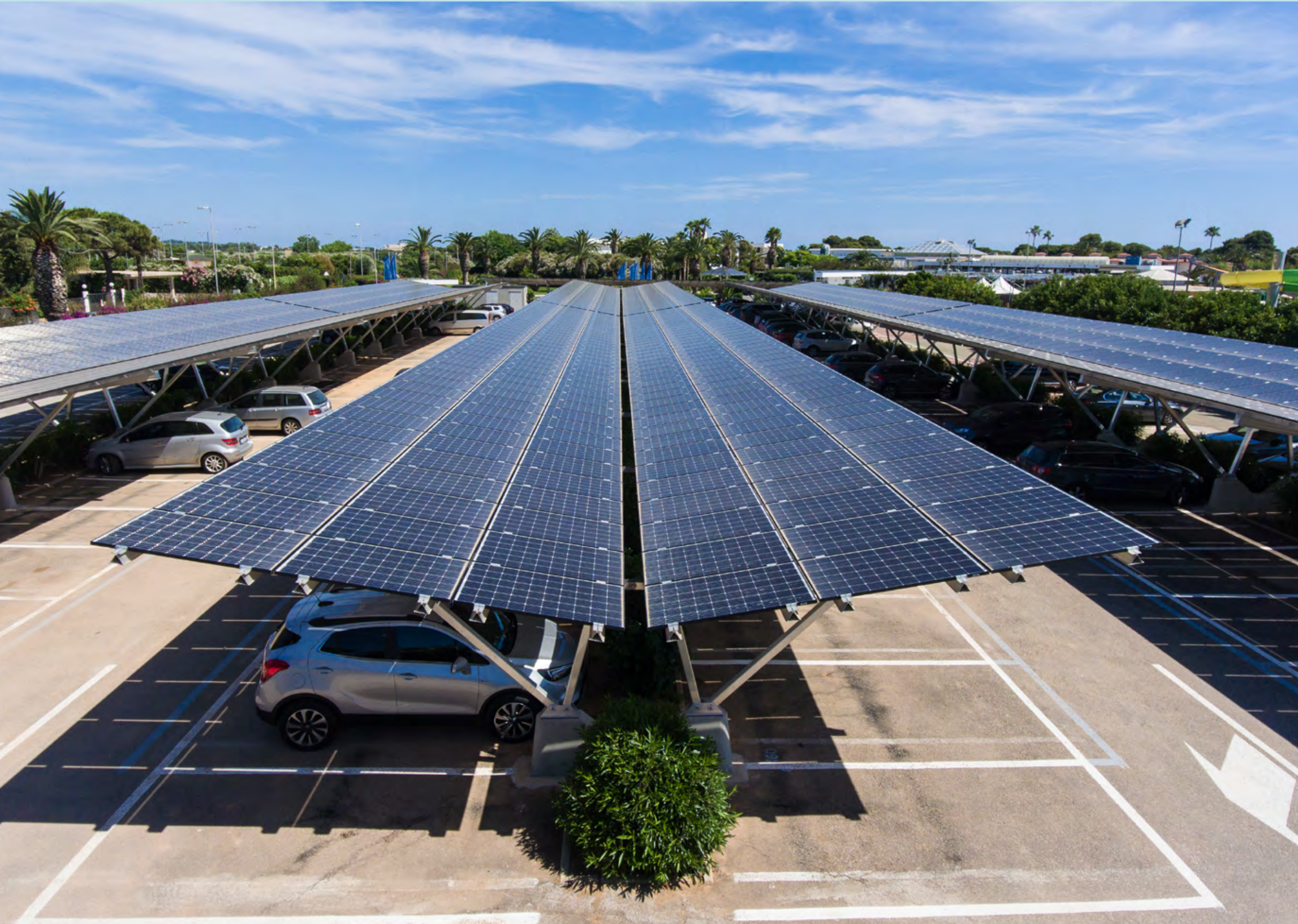
Grüne Energie: Die Photovoltaikanlagen im ROBINSON Club Apulia liefern 1.438 Megawattstunden Strom pro Jahr. 71 Prozent davon dienen der Eigenversorgung der Clubanlage, der Rest fließt in das lokale Stromnetz.
